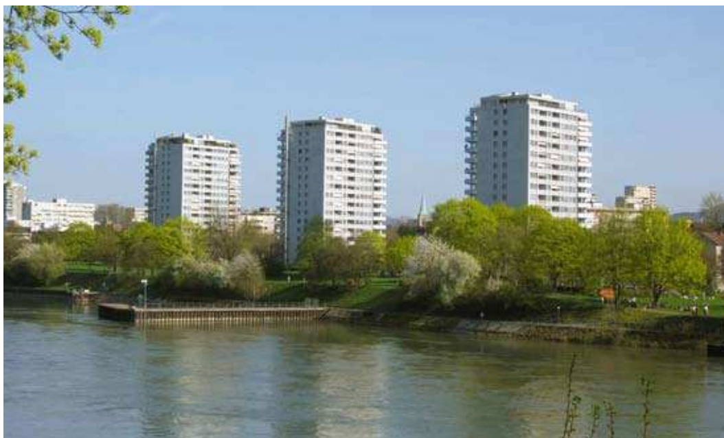
Wohnen im Baurecht – in der Region Basel weit verbreitet. Im Bild eine Anlage in Birsfelden (Bild: Autor)
